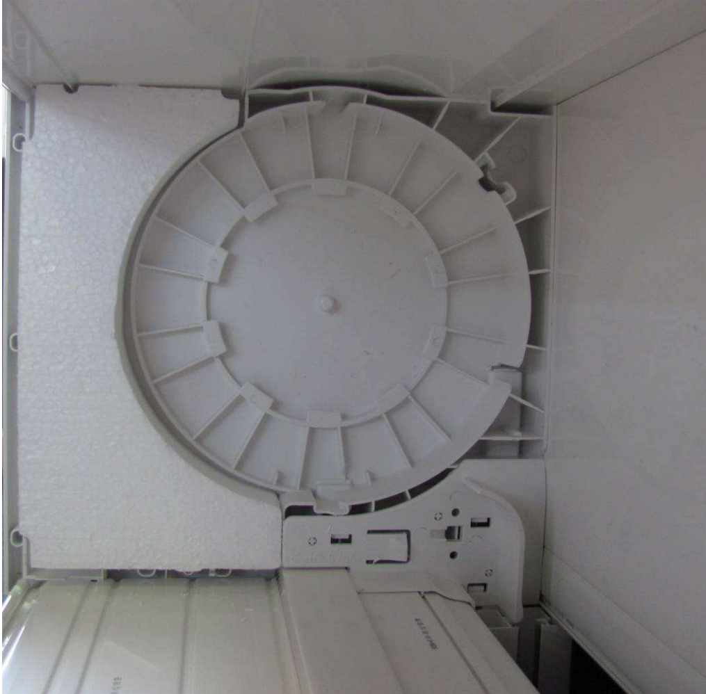
Bild 2 Formschlüssige Ausführung der Kopfstückdämmung
