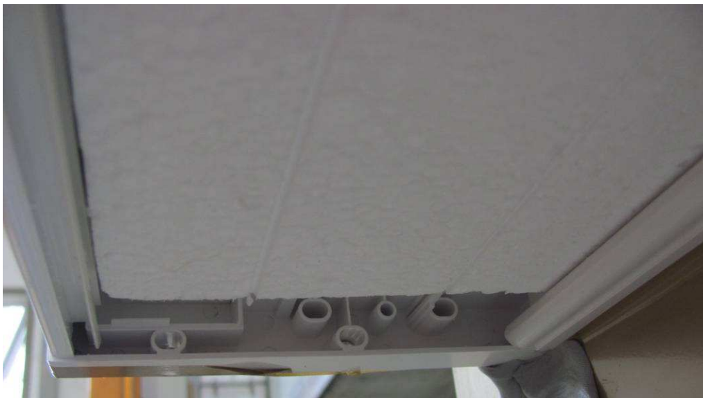
Bild 6 Revisionsöffnung mit EPS- Dämmung
